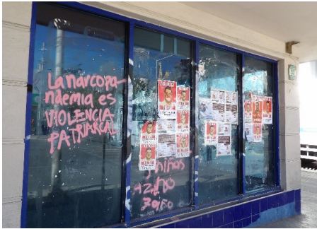
a. Intervención en un muro de Culiacán.
